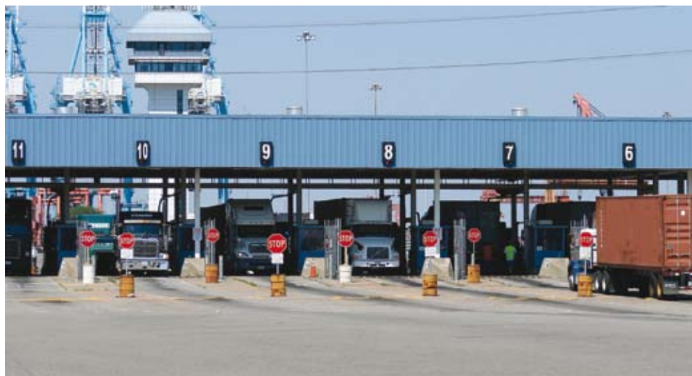
Norfolk International Terminals utiliza 15 básculas con plataforma de hormigón para pesar los camiones que transportan carga desde y hasta el puerto.
